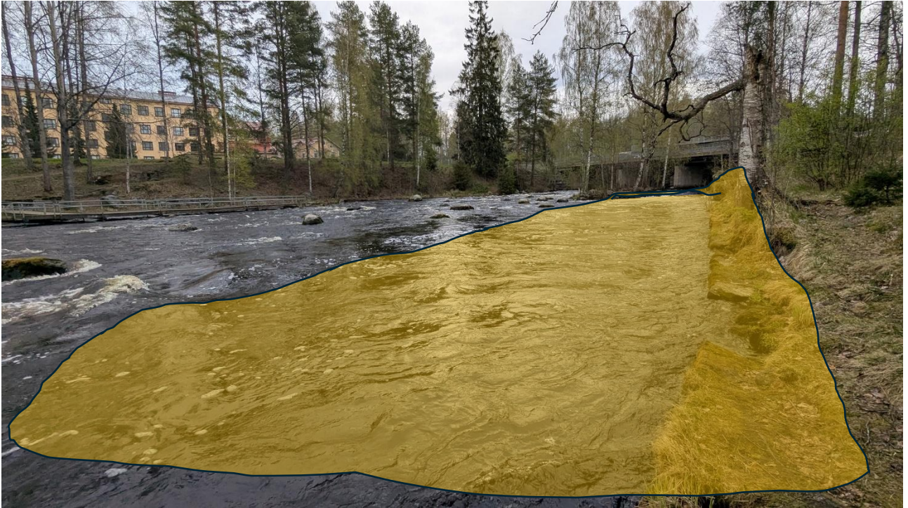
Kuva 7. Voimalaitoskanava keskikohdasta ylävirtaanpäin kuvattuna. Ranta on pengerretty graniittikivillä.
