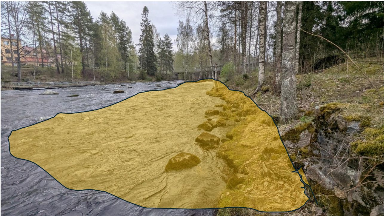
Kuva 8. Voimalaitos kanava alaosalta ylävirtaan päin kuvattuna. Uoman rantaa leventämällä ja kiveämällä saadaan rakennettu ranta-alueita pienille taimenille soveltuvaksi.
