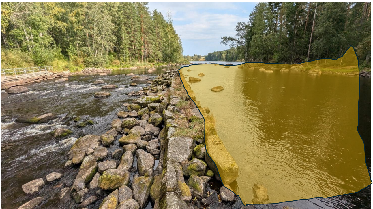
Kuva 5. Luonnonuoman ja voimalaitosuoman välissä oleva riutta. Konkreettinen kuva miten uomat eroavat toisistaan uoman kiveämisen ja virtausolosuhteisen mukaan.
