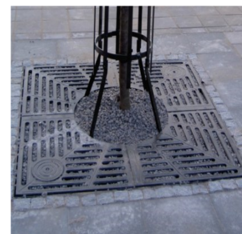
Puun runkosuoja ja vaihtoehtoinen malli maaritilästä ilman integroitua valaisinta. Kuva: Tihveräinen Oy
