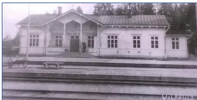
Kivetty välilaituri, kiskot ja rullavaunu 1920-luvulla
